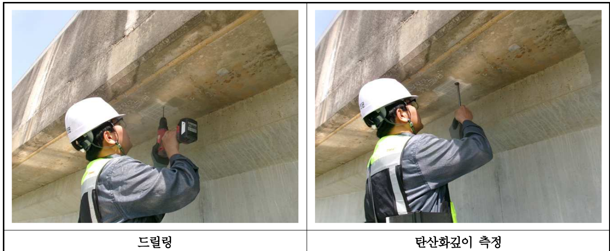
【사진 7.4.3】 탄산화 깊이 측정 현장사진
