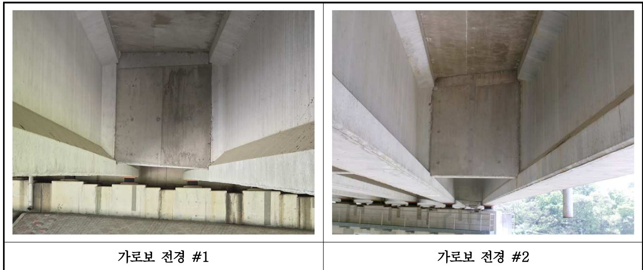
【사진 7.3.6】 가로보 전경
