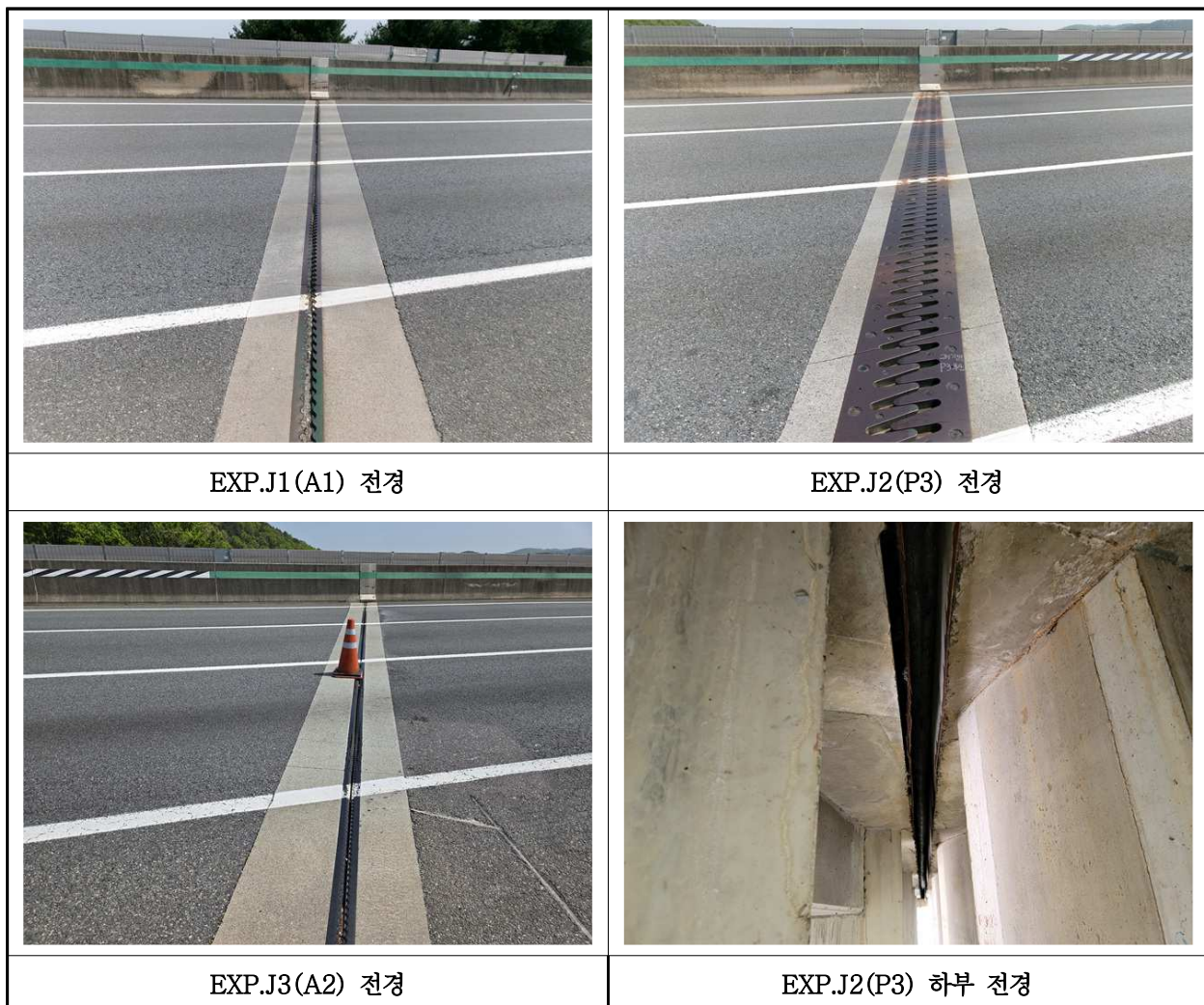
【사진 7.3.17】 신축이음장치 전경
