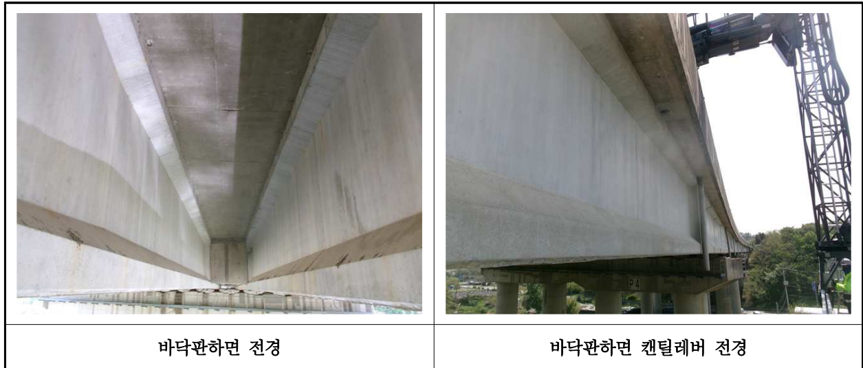
【사진 7.3.2】 바닥판하면 전경
