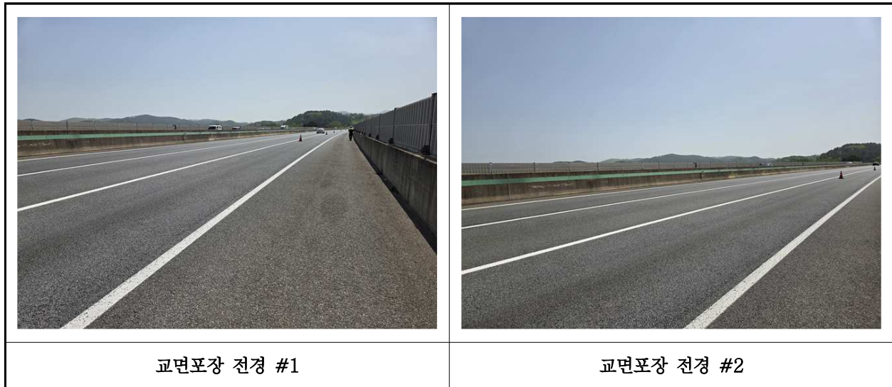
【사진 7.3.20】 교면포장 전경
