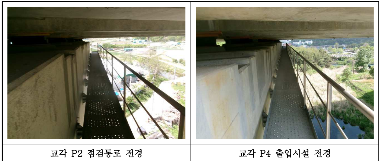
【사진 7.3.26】 교량 점검시설 전경
