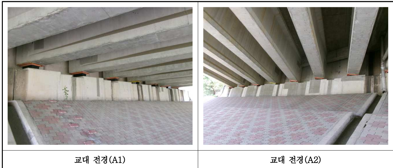
【사진 7.3.8】 교대 전경
