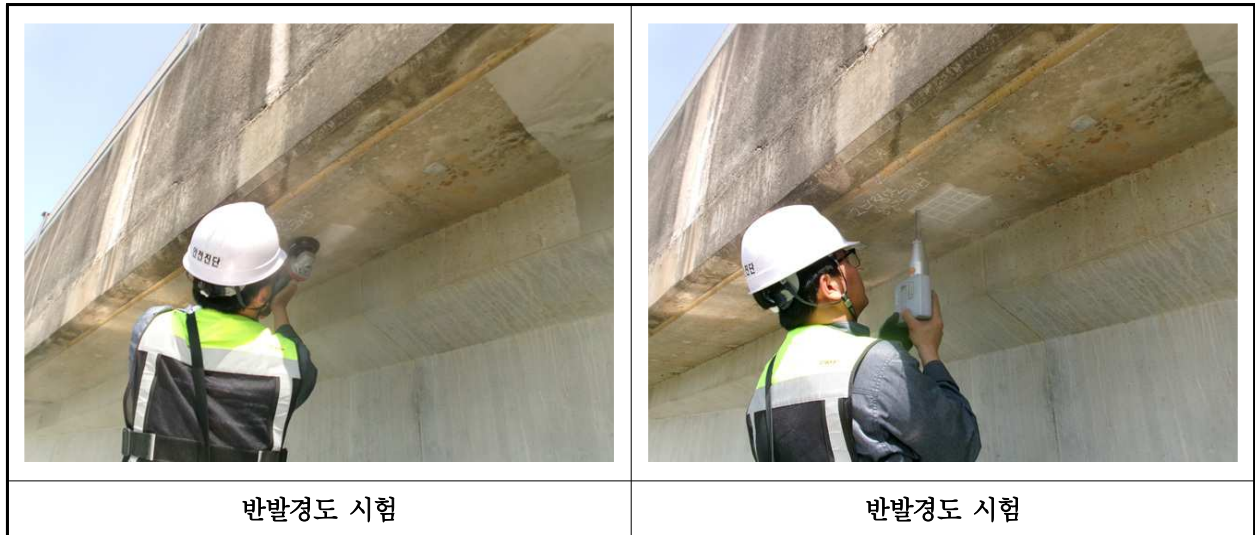
【사진 7.4.2】 반발경도시험 현장사진
