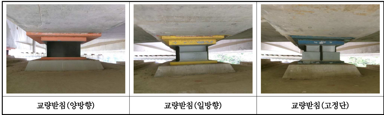
【사진 7.3.13】 교량받침 전경
