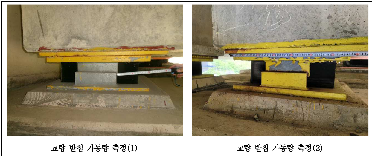
【사진 7.3.16】 교량받침 이동량 측정
