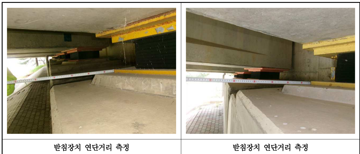
【사진 7.3.15】 교량받침장치 연단거리측정
