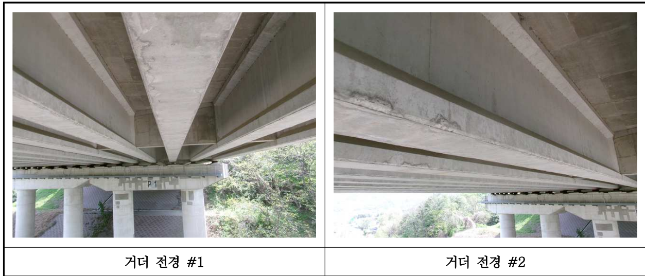
【사진 7.3.4】 거더 전경
